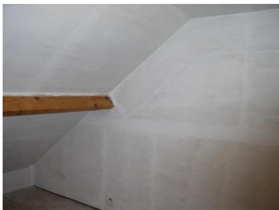
Sur des plaques de plâtre, application d'un primaire au silicate pour réaliser une accroche.
